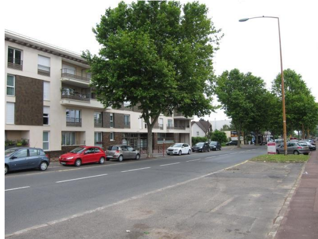
Illustration 164. RD 986 (avenue de la Division Leclerc) à Châtenay-Malabry, source : Groupement SARA
