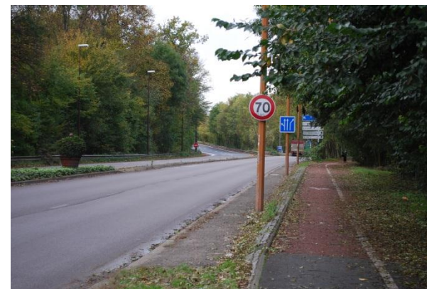
Illustration 198. RD 986 en direction de l'A86 à Châtenay-Malabry, source : Groupement SAR
