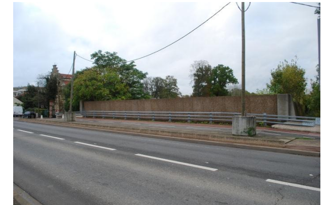
Illustration 200. RD 986 enjambant l'ouvrage de la LGV Atlantique à Châtenay-Malabry, source : Groupement SARA
