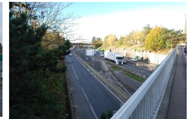
Illustration 202. A 86 passant sous la RD 986 à Antony, Source : Groupement SARA
